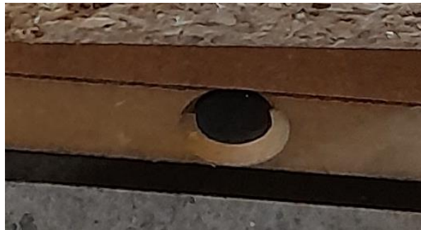
Figura 4. Ejemplo de inserción de tag adecuada
